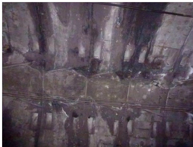
Figura 75 – Stato dell'armamento in corrispondenza della nicchia 570
