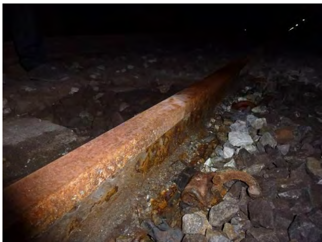
Figura 74 – Stato dell'armamento in corrispondenza della nicchia 570
