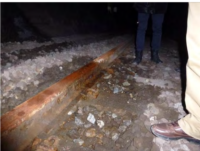
Figura 70- Stato dell'armamento in corrispondenza della nicchia 695
