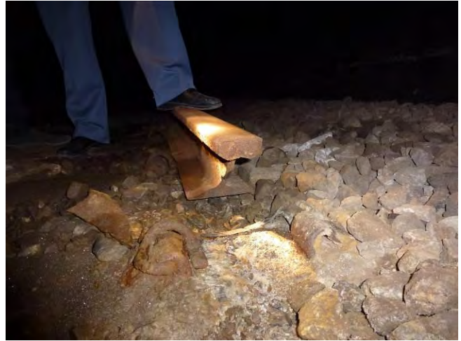
Figura 28 - Punto di rottura della rotaia al km 5+710, vista in direzione Castiglione Cosentino
