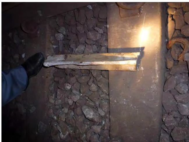
Figura 49 – Parte della rotaia rotta (5)
