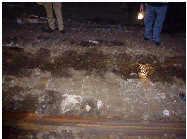
Figura 40 – Prospetto delle 4 traverse e dei 4 attacchi in corrispondenza dello spezzone di rotaia distaccata al km 5+710
