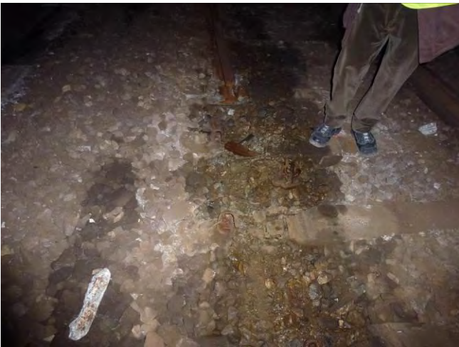
Figura 33 - Punto di rottura della rotaia al km 5+710, vista in direzione Paola
