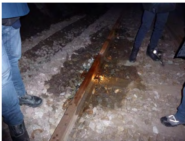
Figura 76 – Stato dell'armamento in corrispondenza della nicchia 570
