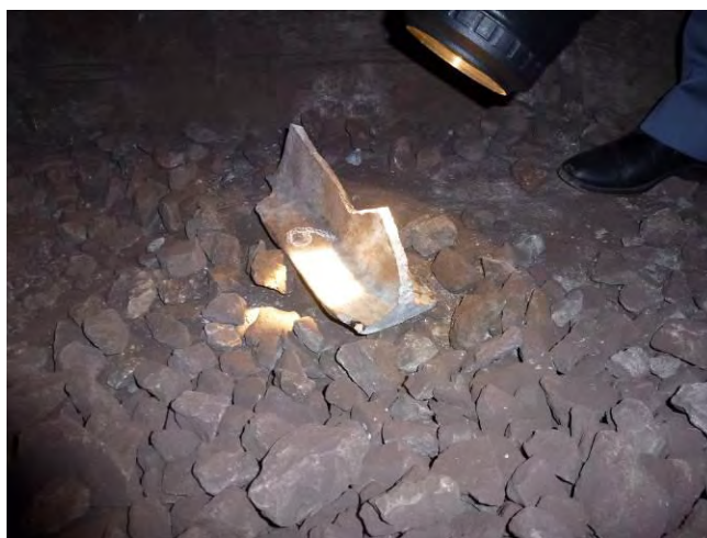
Figura 52 - Parte della rotaia rotta (6)
