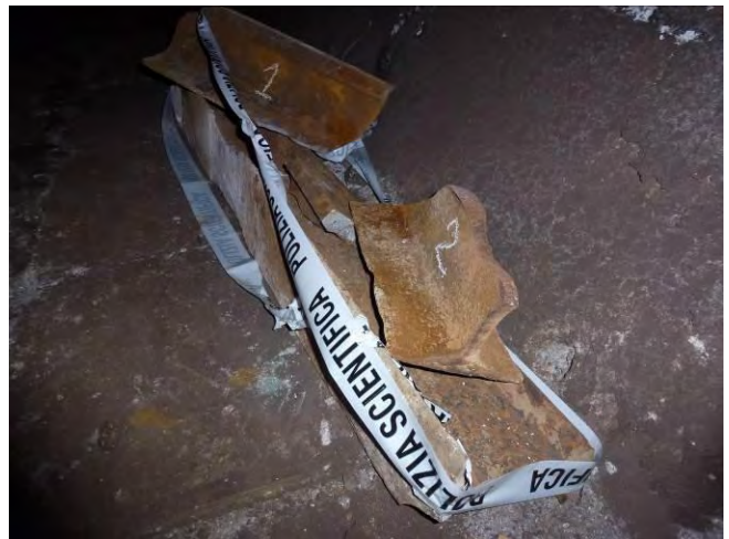
Figura 46 - Parti della rotaia rotta (1) (2) e (3)
