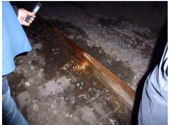
Figura 69 - Stato dell'armamento in corrispondenza della nicchia 695
