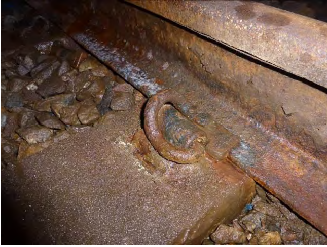
Figura 60 - Altro attacco della rotaia destra smt in corrispondenza del punto di distacco dello spezzone di rotaia sinistra smt al km 5+710
