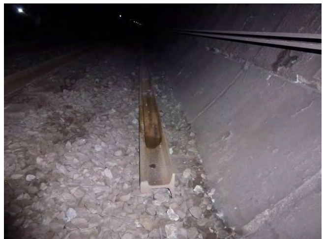
Figura 71 – Barra di rotaia da porre in opera
