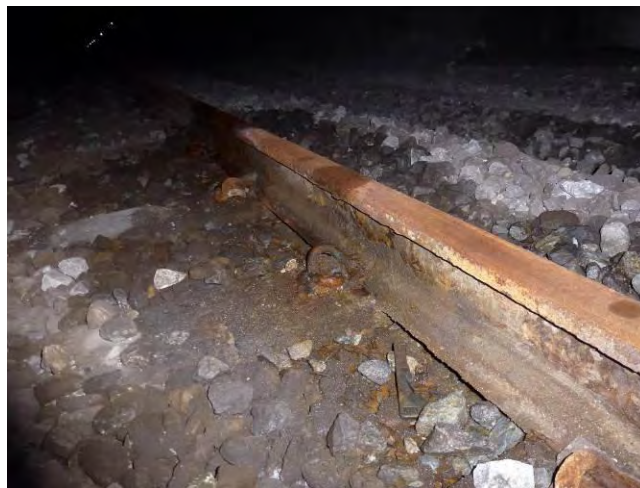
Figura 73 – Stato dell'armamento in corrispondenza della nicchia 570
