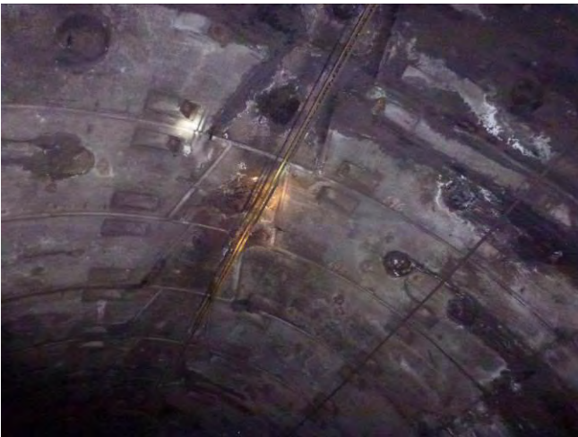
Figura 68 - Stato dell'armamento in corrispondenza della nicchia 695
