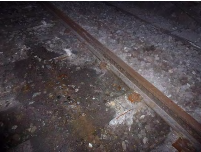
Figura 66– Stato dell'armamento in corrispondenza della nicchia 695
