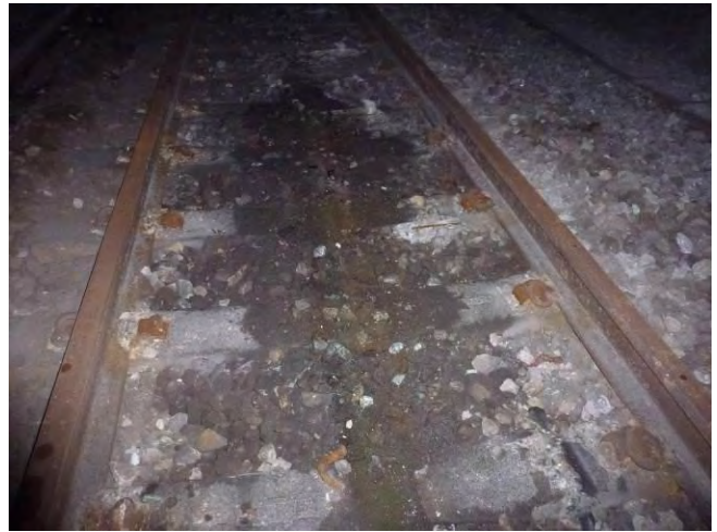
Figura 67 - Stato dell'armamento in corrispondenza della nicchia 695
