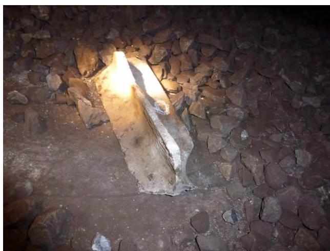
Figura 54 - Parte della rotaia rotta (6)
