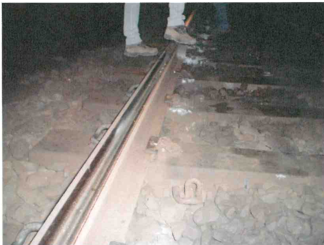
Figura 11- Segni di caduta sulle traverse
