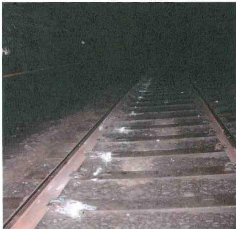
Figura 5 – Primi segni della caduta di una ruota sulle traverse (fonte: RFI)
