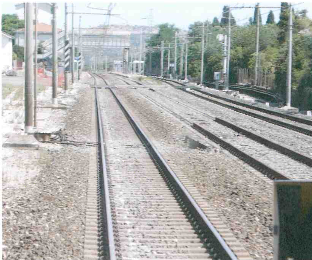
Figura 14 - Segni di impatto sulle traverse (stazione di Itri)
