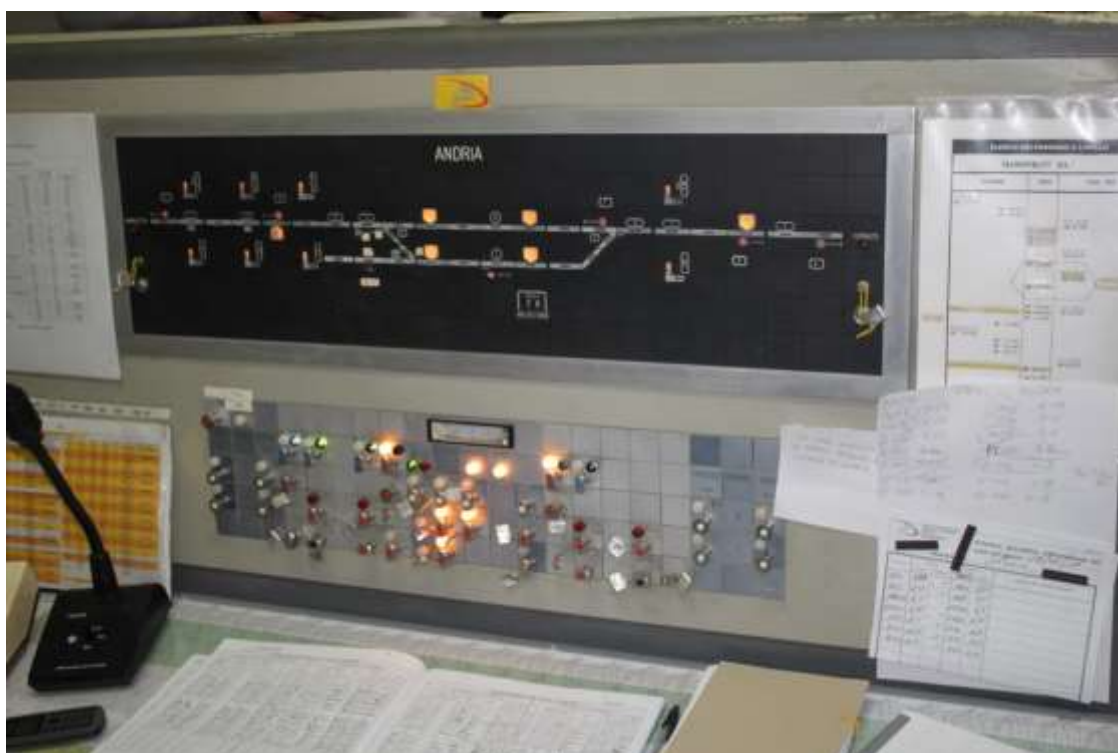
Figura 16 - Banco di manovra della stazione di Andria
