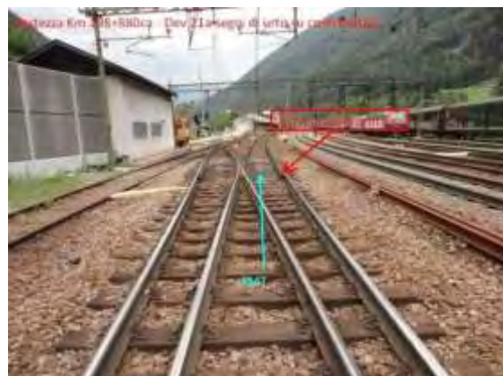
Figura 13 Fortezza segni deviatoio 21a (Foto RFI)
