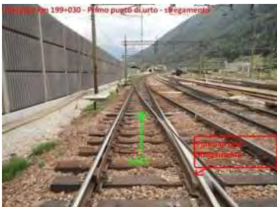
Figura 12 Fortezza segni deviatoio 25a (Foto RFI)
